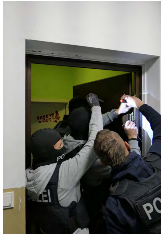
Die Tür wird wieder eingesetzt und eigentumsicher verschlossen.
