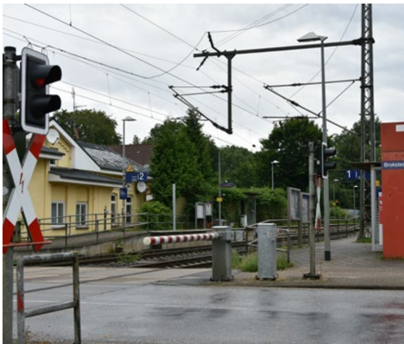
Bahnübergang Brokstedt heute
