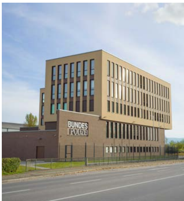
Dienstgebäude der Bundespolizeiinspektion Offenburg
