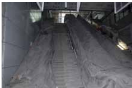
Gigantische Rolltreppen über mehrere Stockwerke – abgedeckt, um sie vor Staub zu schützen
