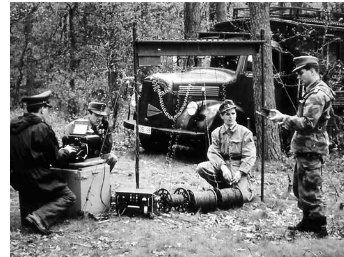
Feldkabelbau im Gelände
