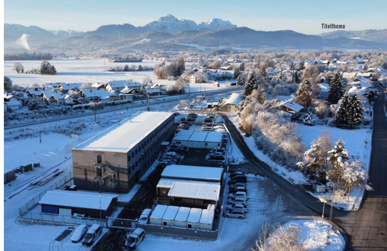
Die Liegenschaft der Bundespolizeiinspektion Freilassing im Winter
