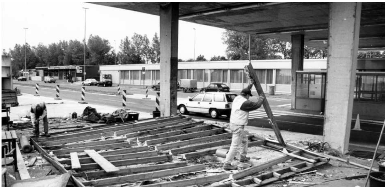
Im März 1995 wurde der Grenzübergang Aachen Nord abgerissen.
