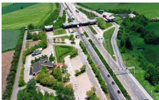
Luftbild der Grenzübergangsstelle Ellund Autobahn
