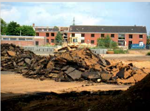
Abriss der Hundertschaftsgebäude im Jahr 2002
