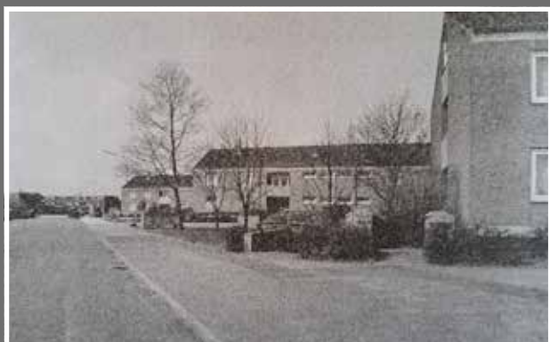
Hundertschaftsgebäude entlang der Ringstraße
