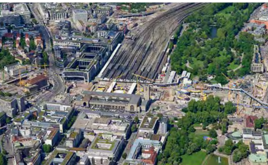
25 Jahre nach Planungsbeginn: Blick auf eine der größten Baustellen Europas
