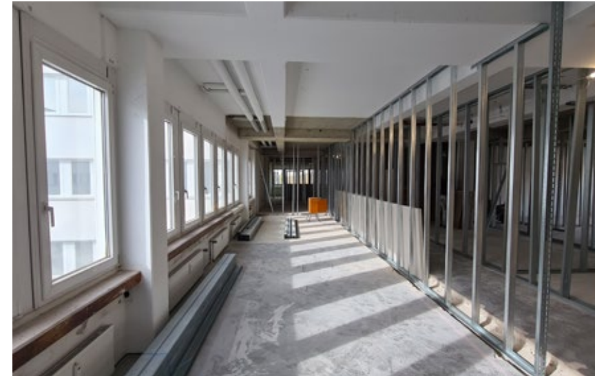
Entkernung und Sanierung: Wände werden eingezogen, Räume neu aufgeteilt und Bodenbelag verlegt.
