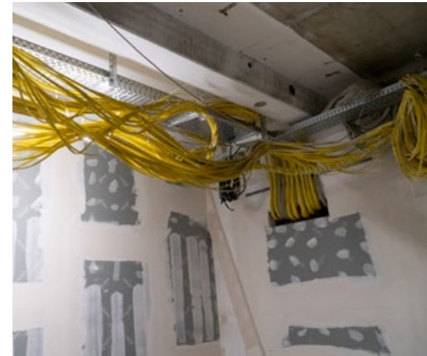
Für den neuen Serverraum wurden jede Menge Kabel verlegt.
