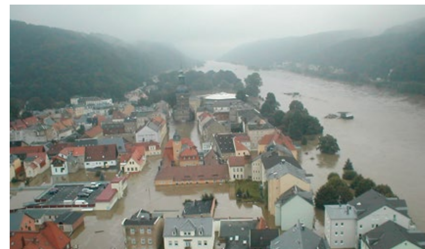
Überfluteter Stadtkern von Bad Schandau.
