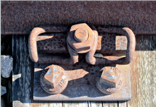
Kleinteil zur Befestigung von Schienen (Stahl)
